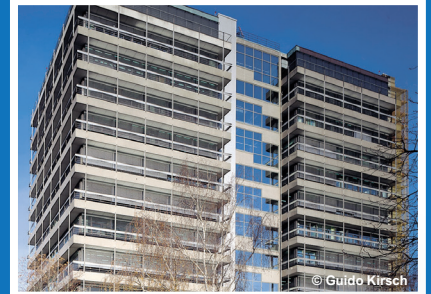
Albert-Ludwigs-Universität Freiburg, Chemie-Hochhaus
