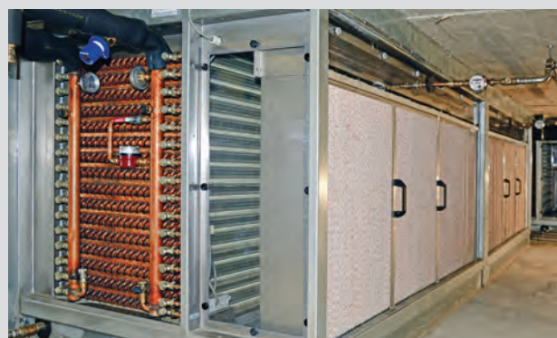
GSWT®-Technologie freistehend in engeren Lüftungskanälen
