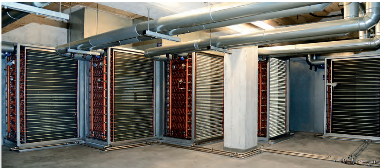
GSWT®-Technologie freistehend in großen Lüftungskanälen
