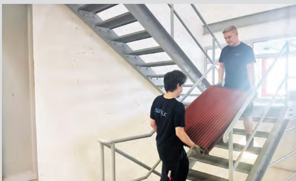
Modulare Einbringung in beengten Verhältnissen ohne bauseitige Öffnung der Technikzentralen
