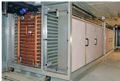
Die GSWT ® -Technologie freistehend in engeren Lüftungskanälen
