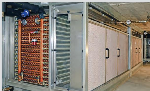
GSWT®-Technologie freistehend in engeren Lüftungskanälen
