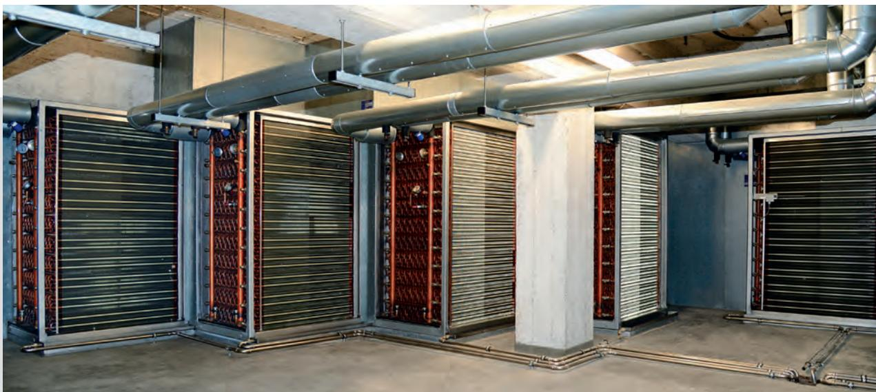
GSWT®-Technologie freistehend in großen Lüftungskanälen
