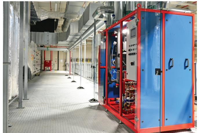
Das Herzstück der multifunktionalen GSWT®-Technologie ist die Pumpen-Armaturenbaugruppe (PAG) von SEW®. Von ihr aus wird das Kreislaufverbundsystem geregelt und Leistung eingespart.
