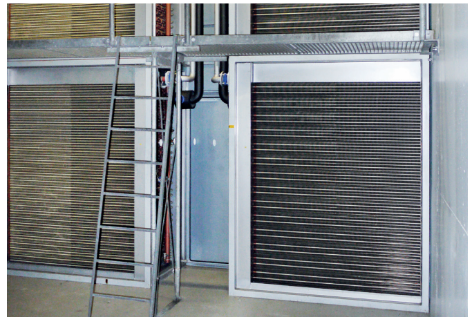
In Rohrrahmengestellen montierte GSWT®-Wärmetauscher kommen zur freien Aufstellung im Ansaugbauwerk zum Einsatz.
