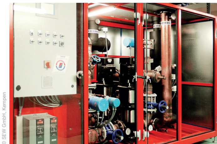
Die Pumpen- und Armaturen-Baugruppe (PAG) von SEW® als konsequente Schnittstelle für das Kreislaufverbundsystem.
