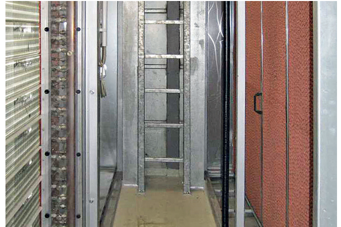
Die vor den Fortluft-Wärmetauschern installierten Wabenbefeuchter erzeugen eine Kälteleistung von bis zu 3,5 kW je 1.000 m³/h, ohne mechanische Kältetechnik.
